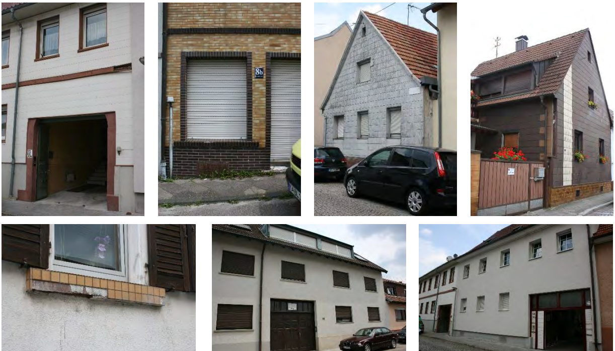
Abbildung 19: Bauliche Veränderungen durch unpassende Fassadenverkleidungen, liegende Fensterformate, große Dachgauben
