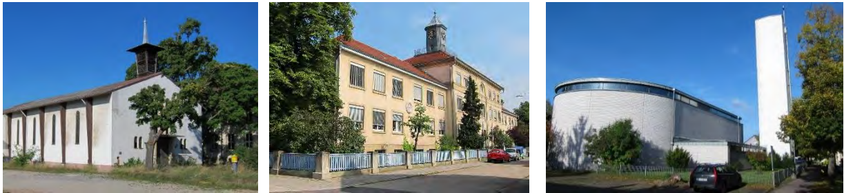
Abbildung 30: Leerstehende ehemalige Militärkirche, Viktor-von-Scheffel-Schule, Kath. Kirche in Neu-Knielingen, Quelle: Stadt Karlsruhe
